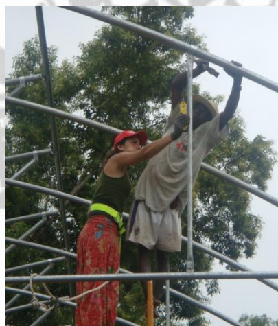
Fig. 2. Irene Moya, Ingeniero Agrónomo construyendo el invernadero. 2008.
