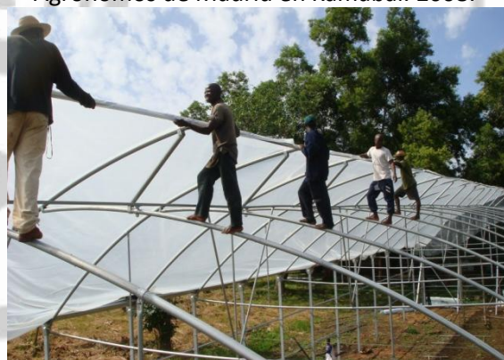
Fig. 3: Técnicos trabajando en la construcción del invernadero en Kamabai. 2008.
